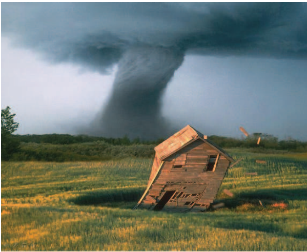
Photo n°3 : Maison détruite par les vents violents d'une tornade
