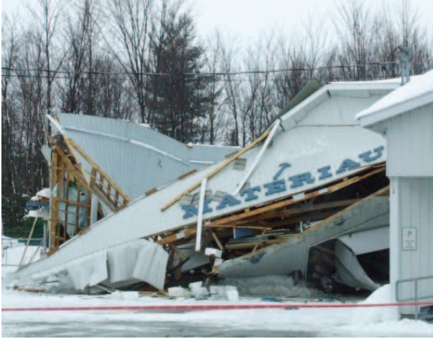
Photo n°1 : Le toit d'un entrepôt effondré par la neige.
